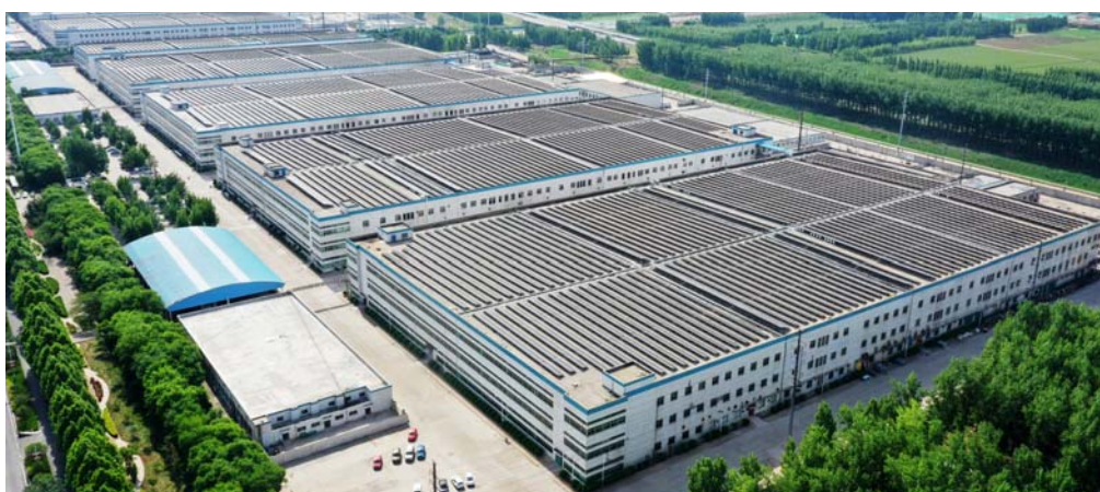
魏桥创业集团厂房顶部光伏发电系统航拍
