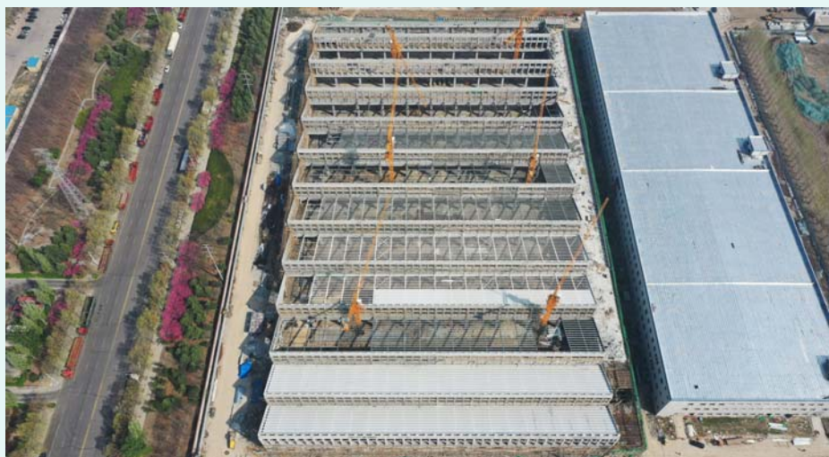
绿色智能印染工厂升级改造项目建设现场
